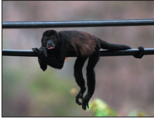
El mono en una línea eléctrica segura y nuevamente-aislado. Howler monkey on a safe, newly-insulated power line.
